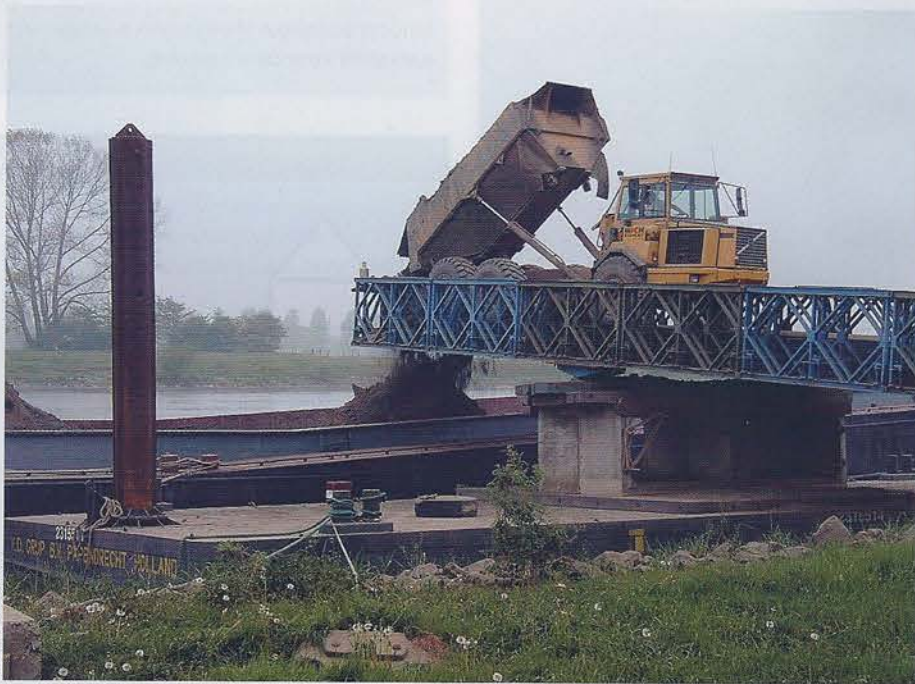
Lossen van grond uit een dumper in een vrachtschip.
