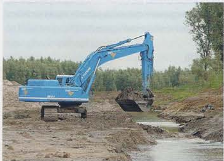
Graafwerkzaamheden aan een nevengeul van de Olster uiterwaarden.
